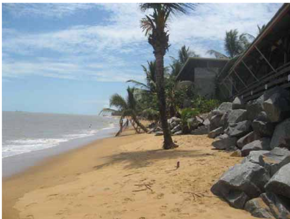
Figure 46 : Protection individuelle par empierrement (source BRGM Guyane)
