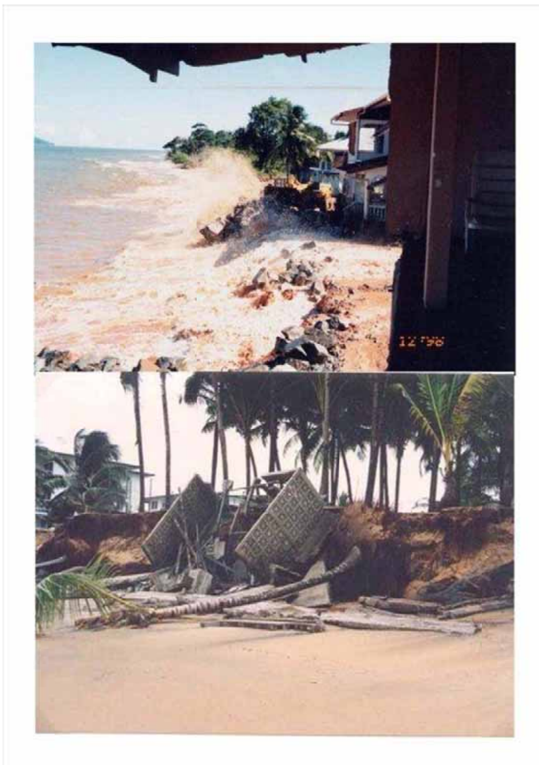
Figure 45 : Destruction de maisons sur les plages de Rémire Montjoly – fin des années '90 (source BRGM Guyane)
